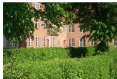
Hæk i gårdrum i belægningsbygning
