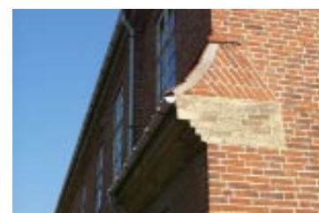
Sålbænk i glaserede røde teglsten
