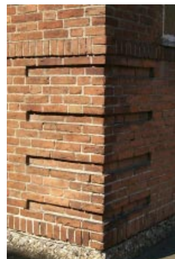
Dekoration i murværk på hjørne
