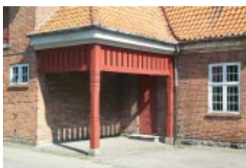
Niche i trækonstruktion
